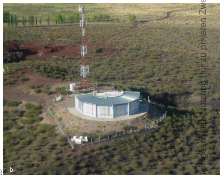
Abb. 5: **Auch dies ist ein Teleskop:** Dieser Wassertank in Argentinien, einer von 1600 des Pierre Auger Observatory, dient dazu unsichtbare kosmische Teilchen höchster Energie nachzuweisen (a). Vier solcher Kamerastationen ergänzen die Oberflächendetektoren: Sie sehen Lichtblitze in der Atmosphäre darüber. In jeder der sechs »Garagen« steckt ein empfindliches Teleskop (b).
